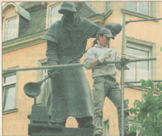
▲ Der Eisengießer wurde für einige Wochen entfernt und wird von Grund auf restauriert.
