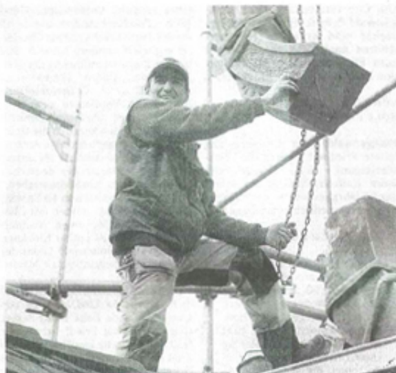
Carsten Alt vom Steinmetzbetrieb Markus Glöckner versetzt ein Giebelstück – in 15 Metern Höhe. Foto: cms/Fötter
